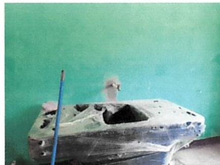
Foto 10: Instalación de pila para cocina finalizado
