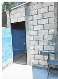
Foto 4: Techo de bodega/pared finalizado
