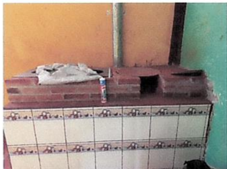
Foto 7: Construcción estufa artesanal finalizado
