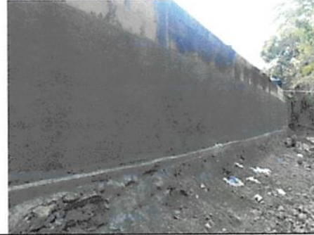
Foto 2: Recubrimiento y repello de muro perimetral finalizado
