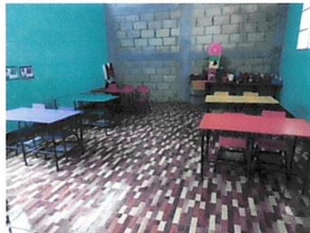
Foto 8: Instalación piso ceramico finalizado
