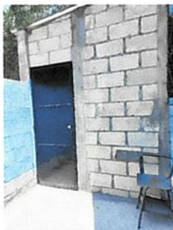
Foto 9: Puerta de metal de bodega/pared finalizado
