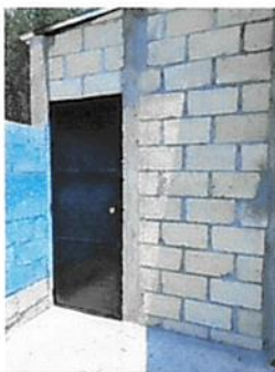
Foto 3: Construcción bodega/pared finalizado
