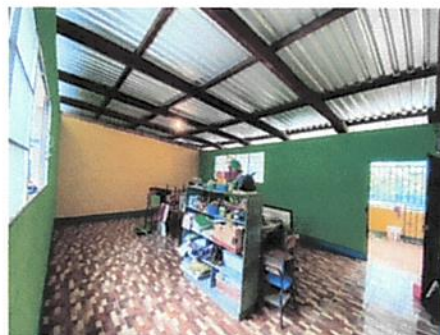
Foto 2: Pared división de aula finalizado
