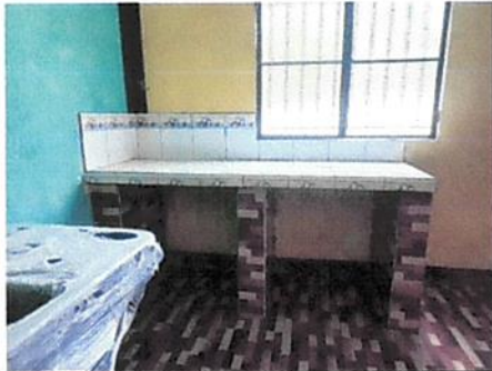
Foto1: Construcción de mesa de cemento para cocina finalizado
