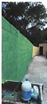
Foto 1: Muro perimetral finalizado
