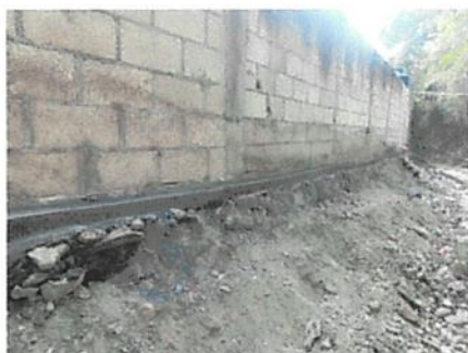
Foto 5: Drenaje para cocina finalizado
